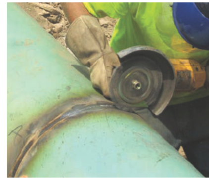
Eliminación de escoria de soldadura antes del siguiente pase de soldadura.
