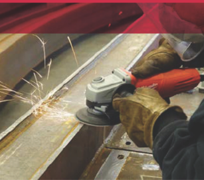
Acabado de rieles metálicos con fibrodisco.
