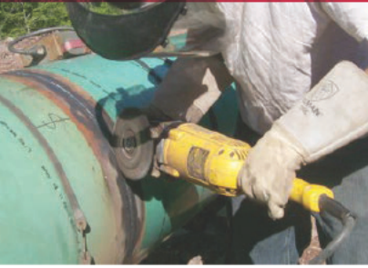
Limpieza de soldadura en unión de tubería
