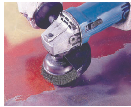
Eliminación de pintura de una lámina de acero.
